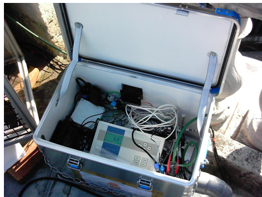
Figure 3-Le pHmètre-conductimètre et la station météo
